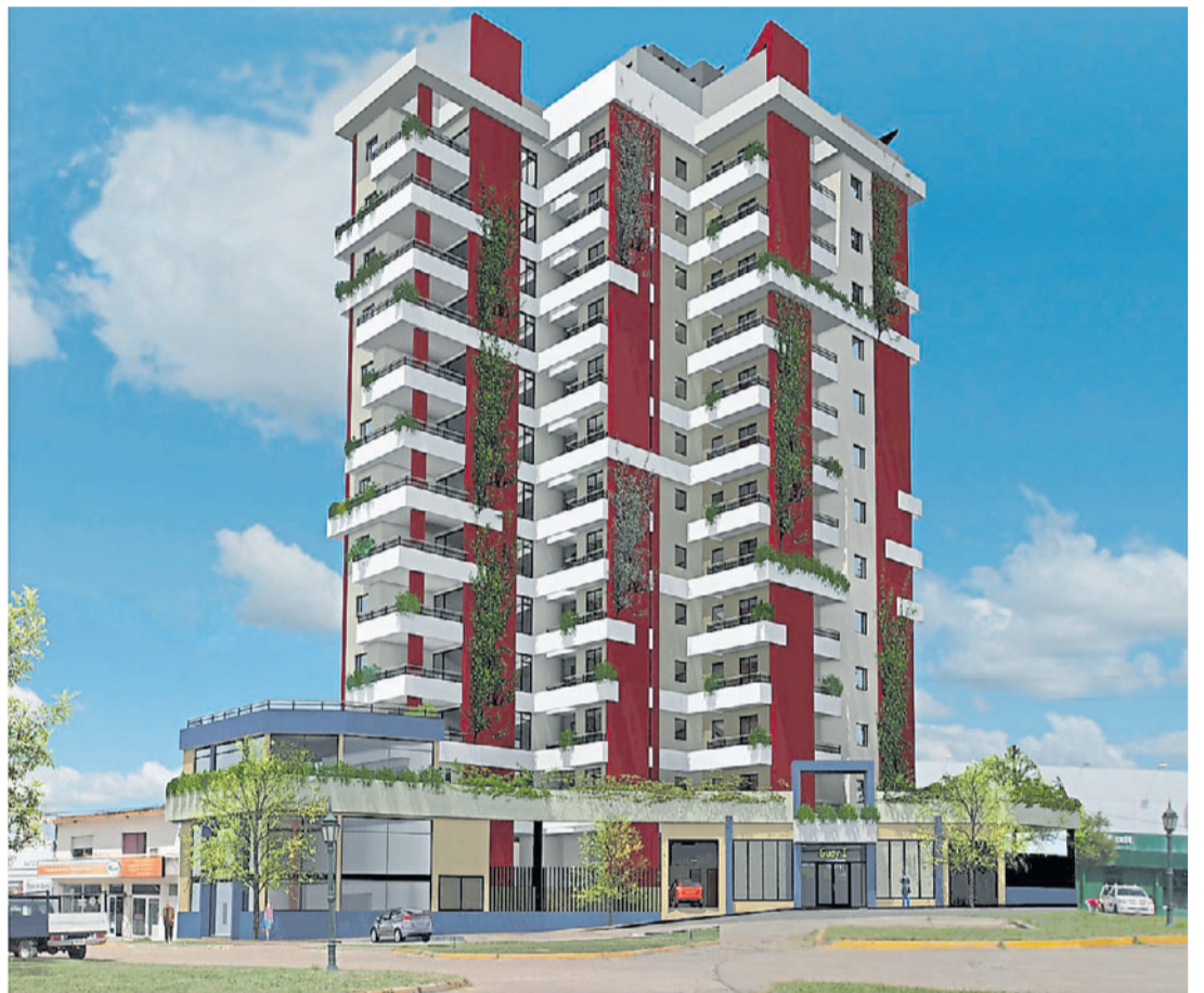
PLASTICIDAD. El entorno despejado hace que la torre tenga una fuerte presencia urbana.
